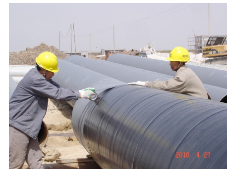
Mise en place manuelle d'un revêtement polymérique anti-corrosion.
